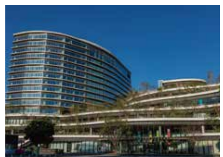
熊本桜町地区第一種市街地再開発工事 空調・自動制御設備工事
