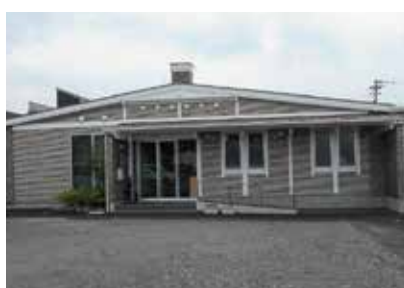
グループホーム | 新築工事
