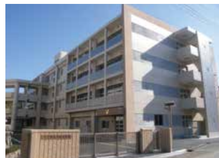
大分市立大在中学校管理・普通・特別教室棟 増改築電気設備工事 【大分市優良建設工事表彰】
