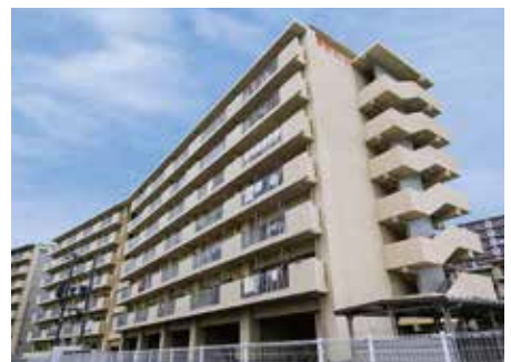
大分県城南住宅S-2棟 新築電気設備工事
