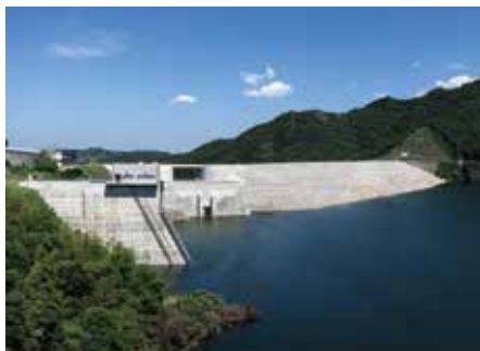
国土交通省 大分川ダム管理庁舎電気設備工事 大分川ダム受変電設備外設置工事
