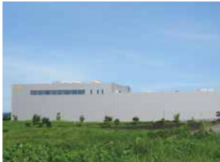
日本マイクロニクス大分工場 新築電気設備工事
