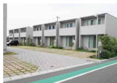
戸建てマンション | 新築工事
