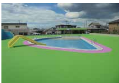
公共プールの改装給排水設備工事
