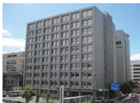
大分県法務総合庁舎 電気設備(通信)工事 【九州地方整備局国土交通行政功労表彰】
