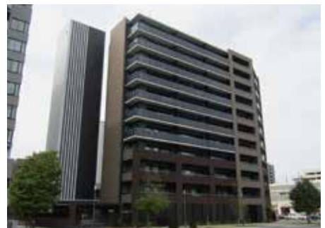
サーパス大分駅前セントマークス 新築工事
