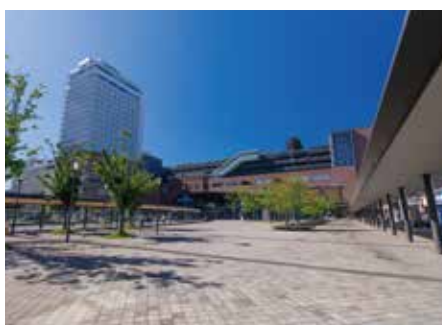
JR大分駅ビル 新築工事 空調・衛生自動制御設備工事
