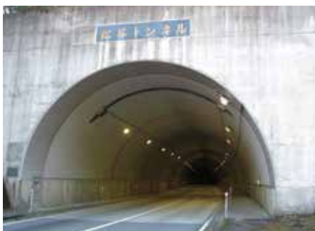
松谷トンネル 照明修繕工事 【大分県土木建築部長表彰】
