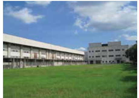
大分市公共下水道原川終末処理場 電気・計装設備改築工事
