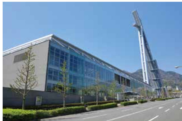
大分県ビーコンプラザグローバルタワー 建設電気設備工事
