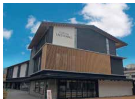
由布市湯布院地域複合施設建設 (電気設備)工事
