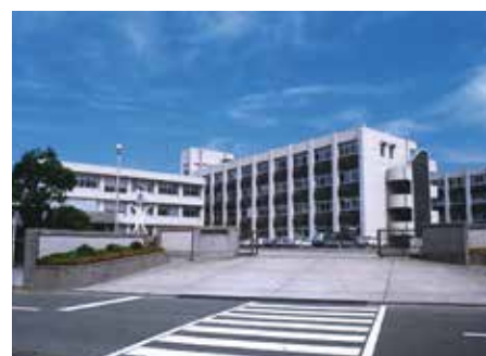
大分県豊府高校 新築電気設備工事 【大分県土木建築部長表彰】
