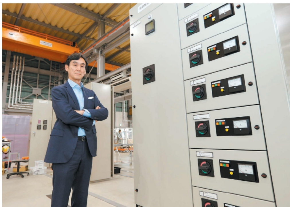
河野電気社長の南公憲さん＝大分市大分流通業務団地の同社配電盤事業部
