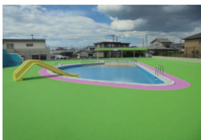
公共プールの改裝給排水設備工事
