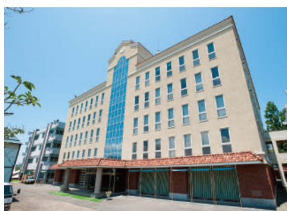
日本文理大学校舎4号館 新築電気設備工事
