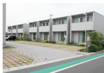
戸建てマンション | 新築工事
