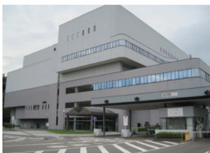
大分市福宗清掃工場 新築工事 空調・衛生 自動制御設備工事
