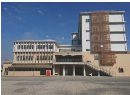
大分市立碩田学園小中一貫校 新築電気設備工事 【大分市優良建設工事表彰】
