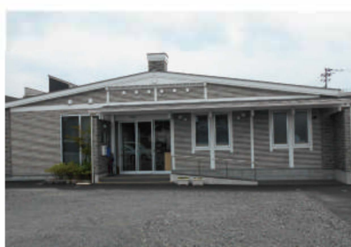
グループホーム | 新築工事
