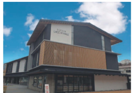
由布市湯布院地域複合施設建設 (電気設備)工事
