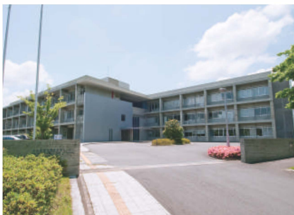
大分県衛生環境研究センター 新築電気設備工事 【大分県土木建築部長表彰】
