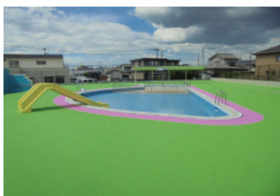
公共プールの改裝給排水設備工事
