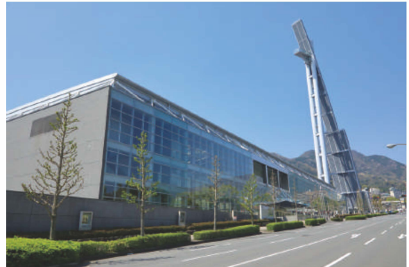
大分県ビーコンプラザグローバルタワー 建設電気設備工事
