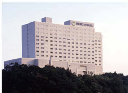
別府湾ロイヤルホテル 新築電気設備工事
