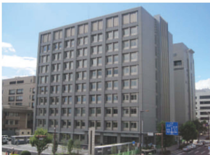
大分法務総合庁舎 電気設備(通信)工事 【九州地方整備局国土交通行政功労表彰】
