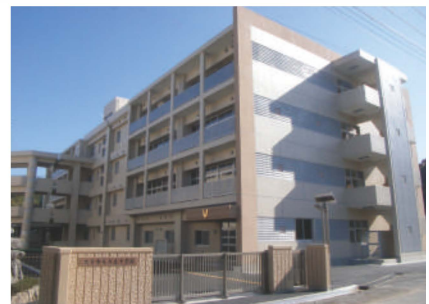
大分市立大在中学校管理・普通・特別教室棟 増改築電気設備工事 【大分市優良建設工事表彰】
