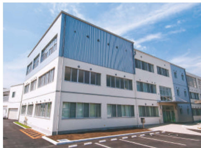
大分県こども家庭センター事務棟 新築電気設備工事 【大分県土木建築部長表彰】
