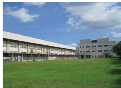
大分市公共下水道原川終末処理場 電気・計装設備改築工事
