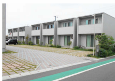
戸建てマンション | 新築工事
